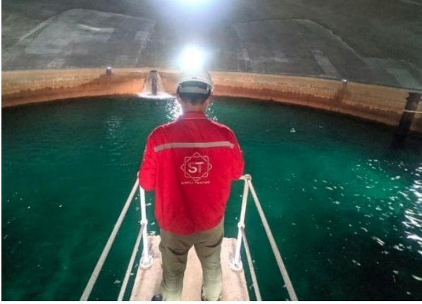
Fig. WTC_M.3.3 فحص خزان المياه
