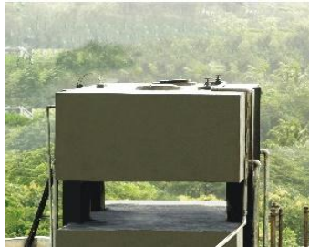
خزانات المياه العلوية الخرسانية
